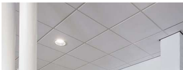
Exemple de réalisation de faux plafond acoustique en dalles de fibre minérales.
